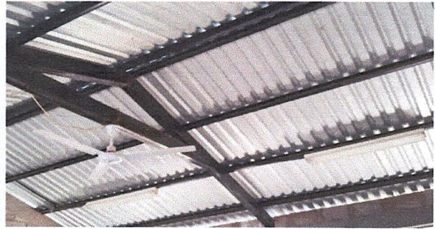
Foto 2: Cubierta de láminas
