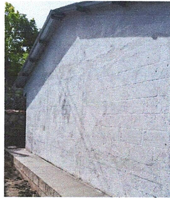
Foto 4: Reparación de repello y cernido de paredes
